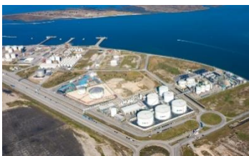
Terminal de Granéis Líquidos
