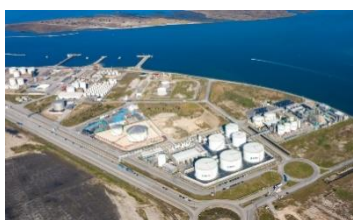
Terminal de Granéis Líquidos
