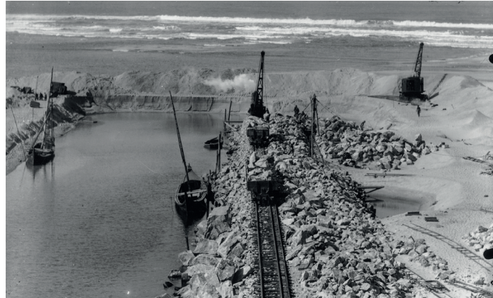
Obras dique marginal, 1934
