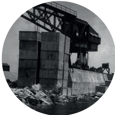
"Titan" nas obras de melhoramento na Barra, 1934
