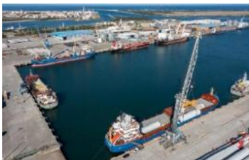
Terminal Norte - Multiusos
